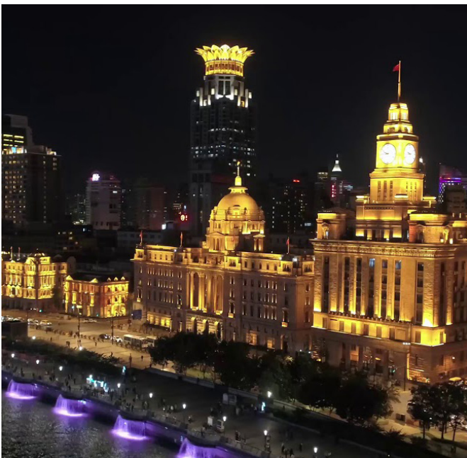
Iluminação dos edifícios históricos de Shanghai em LED
